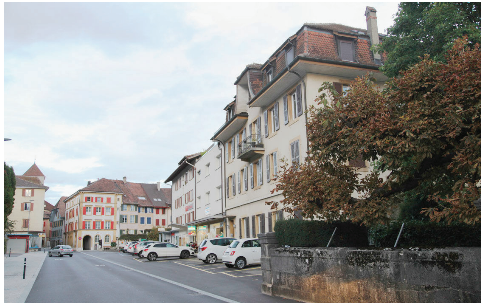
En accord avec Bernard Mosimann, propriétaire du bâtiment (au premier plan), le centre devrait investir les locaux de l'ancien cabinet de ce dernier, juste en dehors de la vieille ville. DSH
