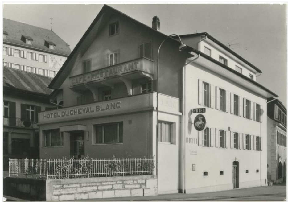
Hôtel-restaurant du Cheval Blanc vers 1960 : Angle sud-ouest du bâtiment.
