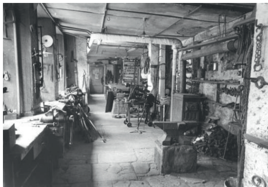
Sainer230 – Photographie : Anonyme, Vue intérieure de la forge Boegli . Reproduction d'un tirage photographique, première moitié du XXe siècle, Mémoires d'Ici.
