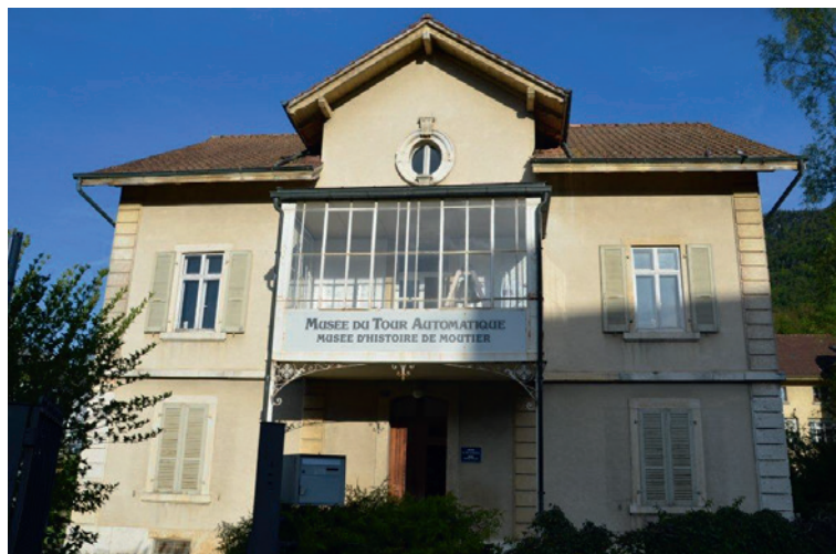
Façade principale de la Villa Junker
